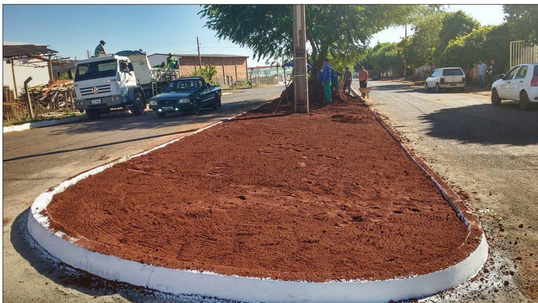
**Figura 08** – Exemplo de canteiro com arremate em meio fio.
