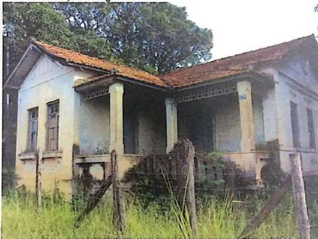
Edificação à Rua José Pedro de Carvalho, nº. 520.
