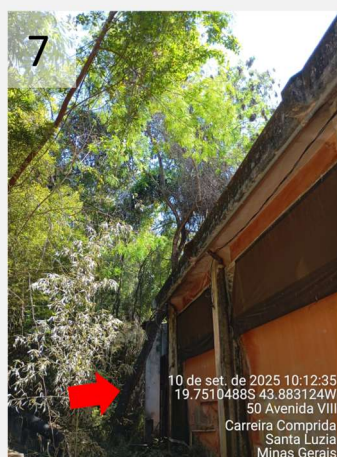
Figura 7 – Evidência ao espécime vistoriado encostado na estrutura da edificação civil
